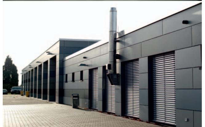
Die alten Fenster wurden erneuert, die Fassade nach den heutigen Energiestandards gedämmt und neu verkleidet und im Inneren wurden sämtliche Oberflächen (Böden und Wände) erneuert und die Wohn- und Aufenthaltsräume neu möbliert.
